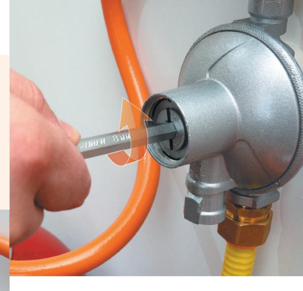
Газобаллонные системы в базовом варианте имеют специальное оснащение в виде автоматического переключающего клапана, производительность которого 10 кг/час. Этот узел отвечает за первую ступень регулировки давления.
