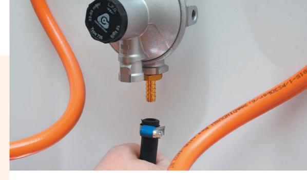
Категорически запрещается подсоединять газовые баллоны посредством водяного или кислородного резинового шланга. Это связано с тем, что резина, из которой он изготовлен, может покрыться трещинами, в результате будет нарушена герметичность.
